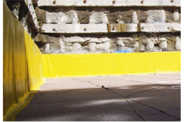
Betonarme Perde Yalıtımı
