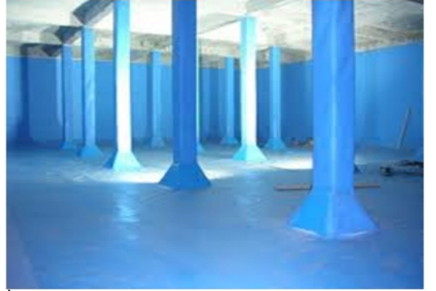
İçme Suyu Deposu Yalıtımı
